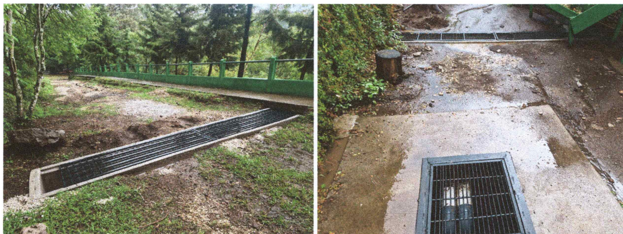
Foto 13 y 14: Zanja y poso de absorción para conservación de suelo y manejo de agua pluvial en el mirador principal y granja educativa
